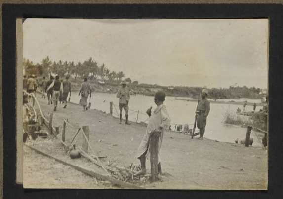
Passerelle à Kilosa E. A. A. Le 10-9-1917
