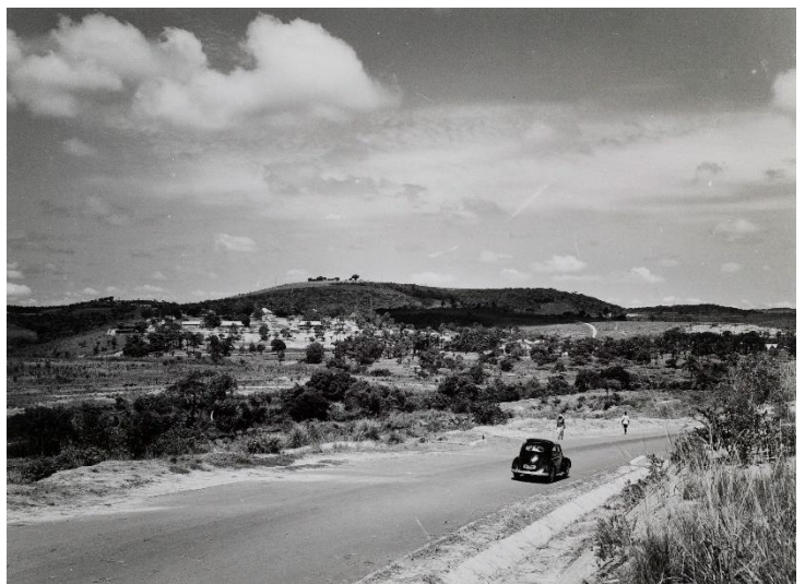
Vue de Kasangulu : la route qui relie la capitale congolaise au port de Matadi AML 00671/0857
