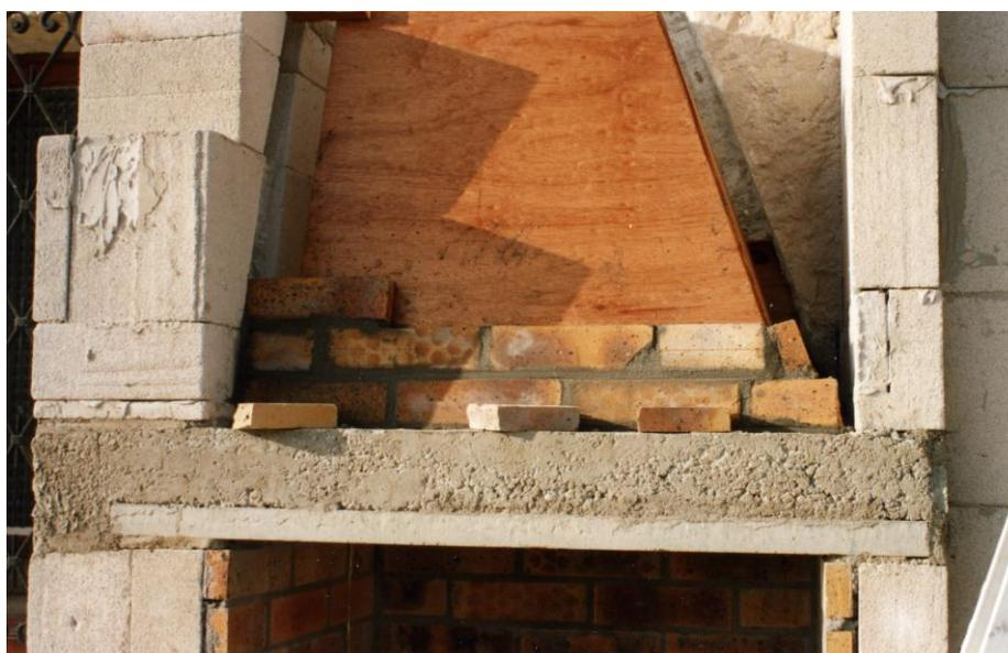
On peut voir que j'avais aussi coulé une poutre en béton armé posée sur une plaque de même composition que les blocs.
